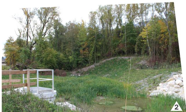
2. Le Bassin du Combo, ouvrage de 850 000 € HT a pour but de protéger les habitants d'Aix-les-Bains et de Mouxy des inondations par débordement de la Chaudanne comme ce fut le cas en juillet 1992. Réalisé sous maîtrise d'ouvrage du CISALB, il peut piéger 17 000 m<sup>3</sup> d'eau des crues grâce à une digue de 2 mètres de haut.
