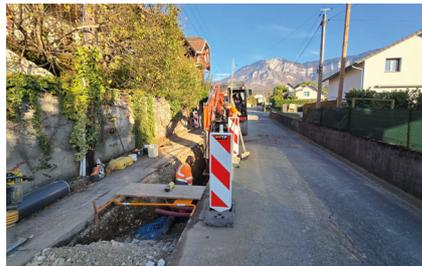
Sur cette artère disposant d'un réseau unitaire eaux usées/eaux pluviales, Grand Lac crée un réseau parallèle pour séparer ces deux éléments. Un sens unique de circulation est mis en place le temps des travaux. Des travaux similaires ont lieu Boulevard Pierpont Morgan, Carrefour des Hôpitaux...
