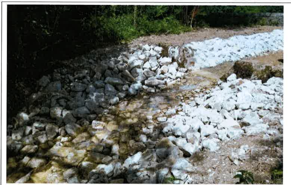
Enrochement du seuil et de la fosse de dissipation
