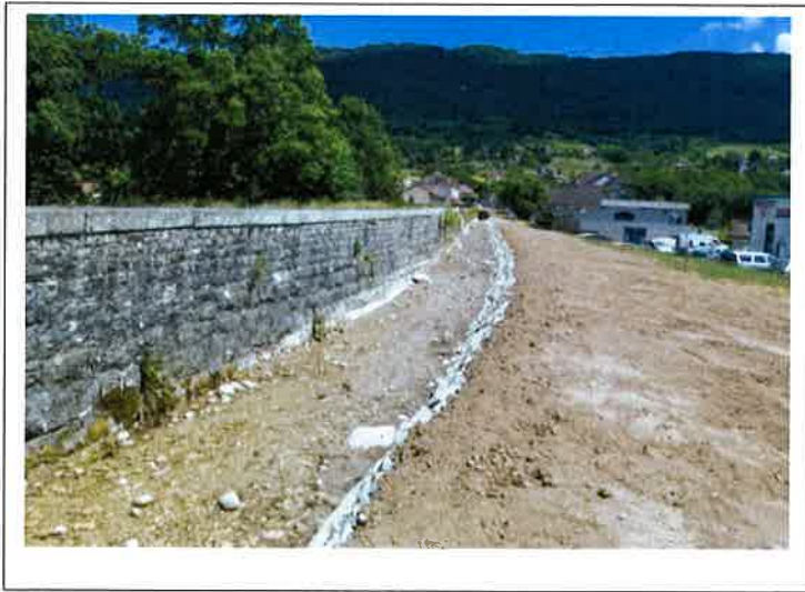
Elargissement du lit du torrent et enrochement de la rive gauche
