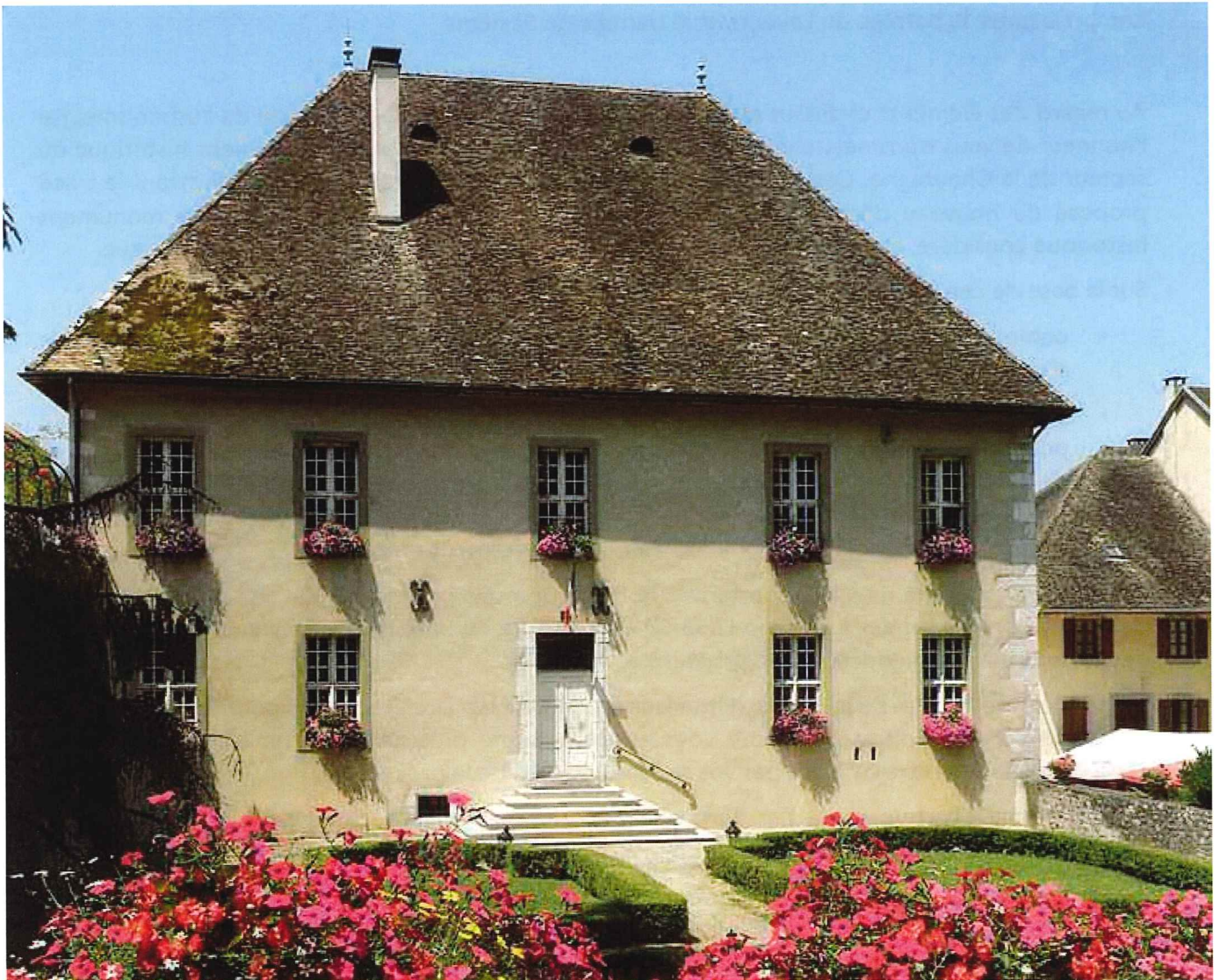
Ancienne maison forte de Boigne Source : Monumentum.fr
