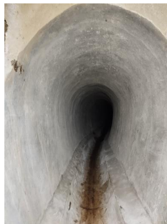
Etat général après travaux
