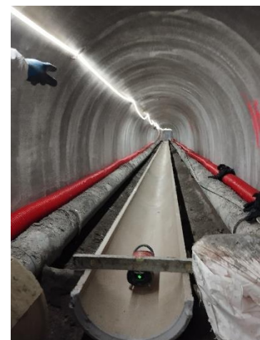
Etat général de l'ouvrage pendant travaux
