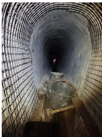
Travaux de renforcement
