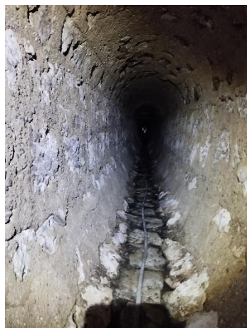
Etat général avant travaux
