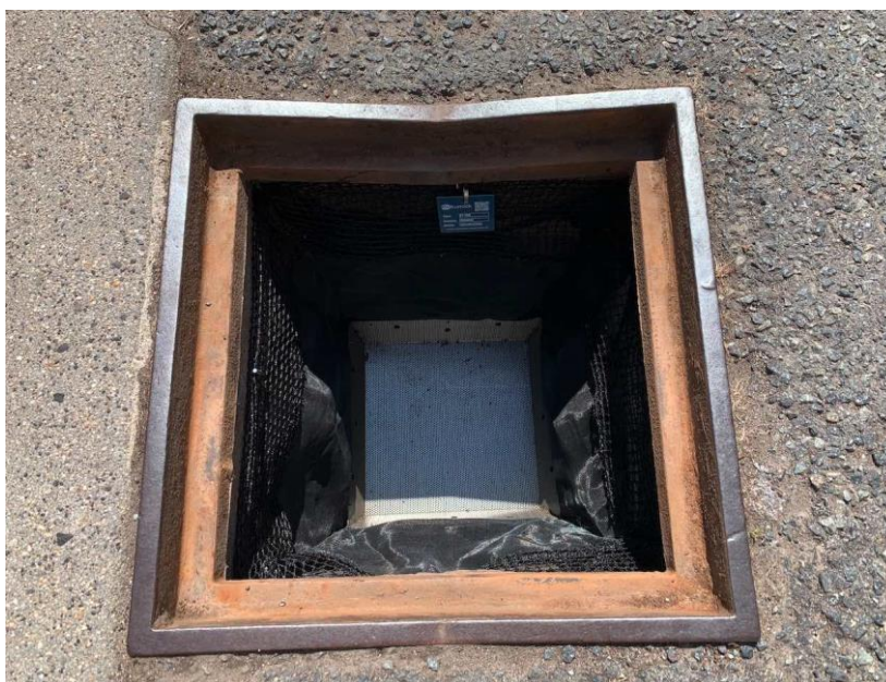
Panier anti-déchets sur grille d'eaux pluviales (source Pollustock)
