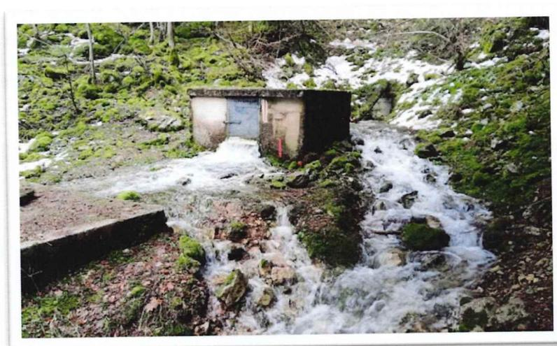
Figure 7 La Meunaz en hautes eaux - l'ouvrage de tête du captage est en mauvais état. Le site connaît des débits importants en période de hautes eaux, qui contournent le captage.
