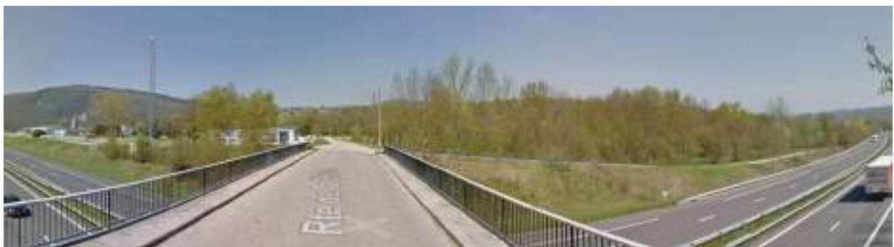
1_Vue depuis la route de Saint Giron, pont au-dessus de l'A41 permettant de desservir la zone : à l'Ouest, la zone existante, à l'Est, les boisements dissimulant le secteur d'extension.
