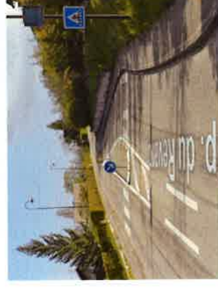
Chicanes et plateaux piétons sur la D913 en milieu urbain (Pugny-Chatenod, Trévignin)
