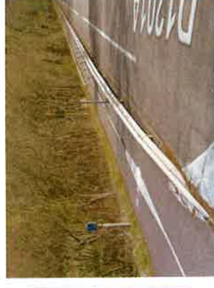
Aménagement V63 au Bourget-du-Lac – source : Google Maps
