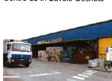
Centre de tri Savoie-Déchets
