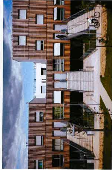
Travail en demi-niveau Adaptation à la pente Stationnement semi-enterré
