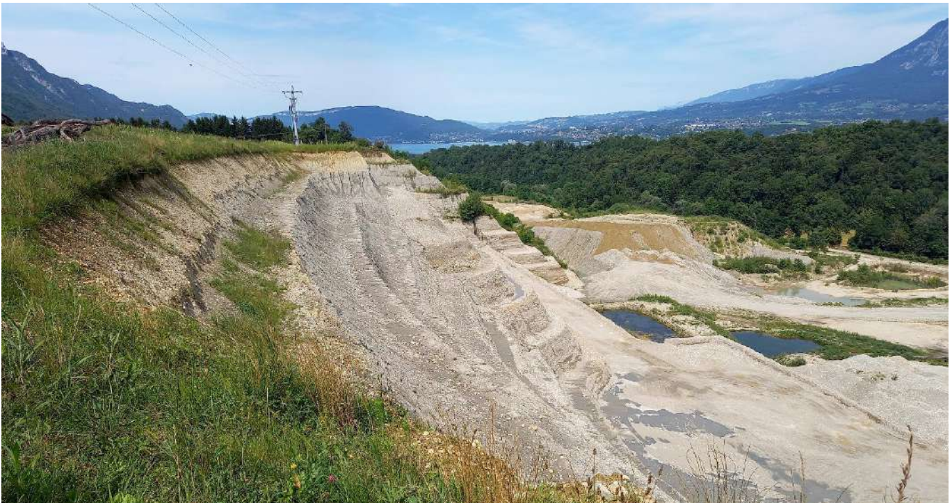
Photographie 1 : Vue de l'exploitation actuelle
