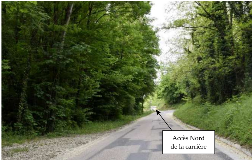
Photographie 34 : Perception du site depuis le Nord de la RD 13, où seule l'entrée du site est visible
