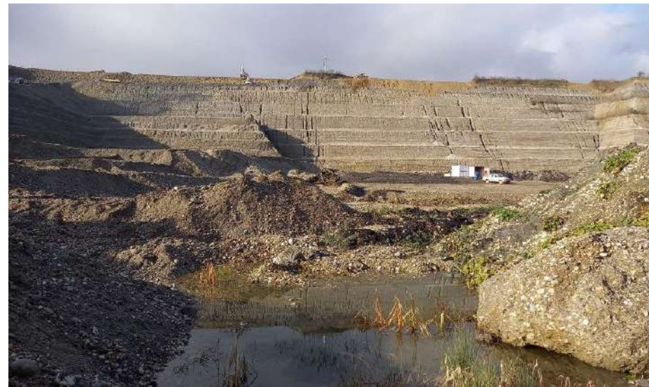
Photographie 8 : Front en cours d'exploitation
