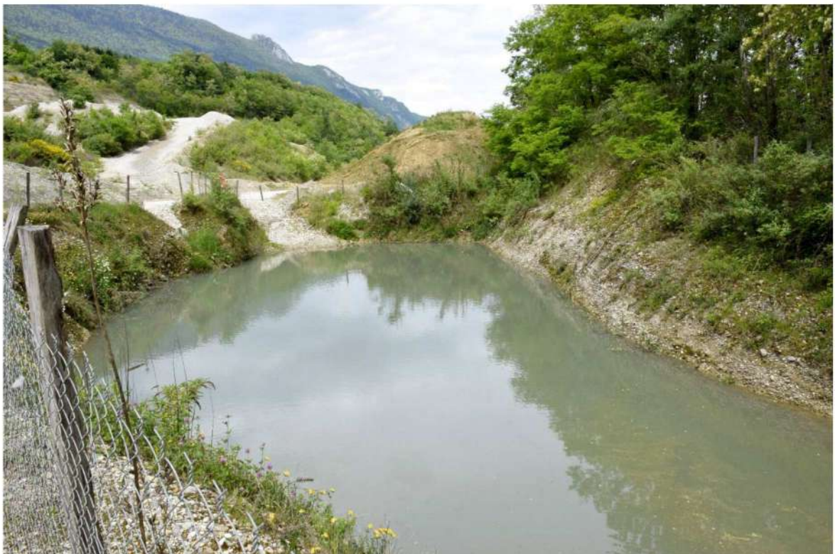
Photographie 6 : Bassin d'infiltration
