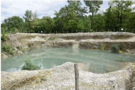
Photographie 10: Bassin d'infiltration
