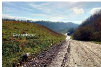
Photographie 14: Zone remise en état après végétalisation remblayé
