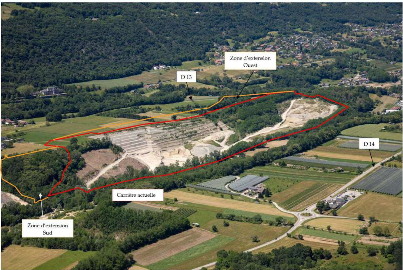
Figure 24 : Photographie aérienne illustrant la carrière actuelle et le projet d'extension
