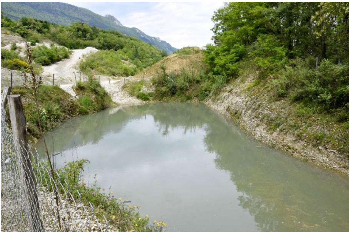
Photographie 6 : Bassin d'infiltration
