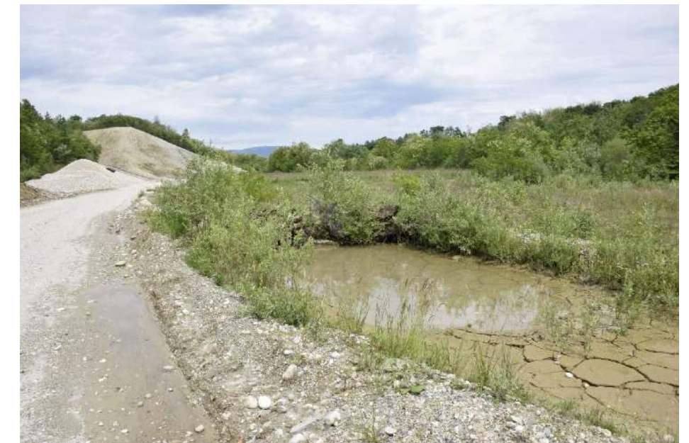
Photographie 12 : Bassin d'infiltration converti en zone humide
