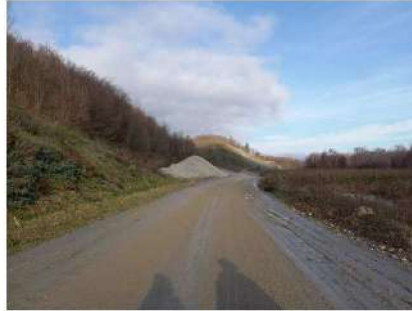
Photographie 11: Piste menant à la zone remise en état
