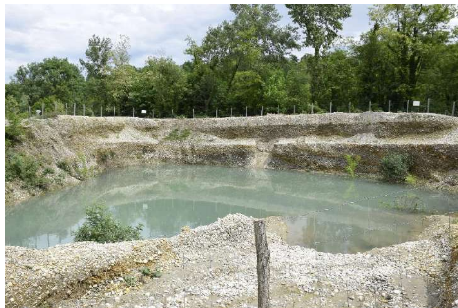
Photographie 10 : Bassin d'infiltration
