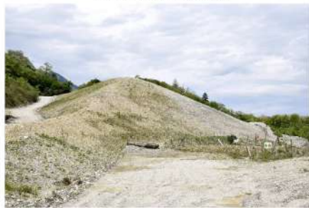
Photographie 13: Zone remise en état (ancien carreau d'exploitation partiellement remblayé)
