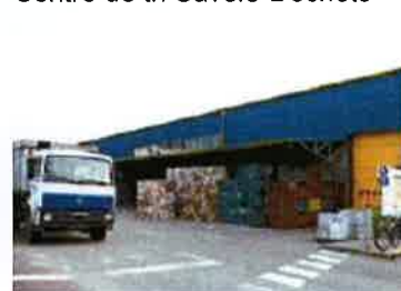
Centre de tri Savoie-Déchets
