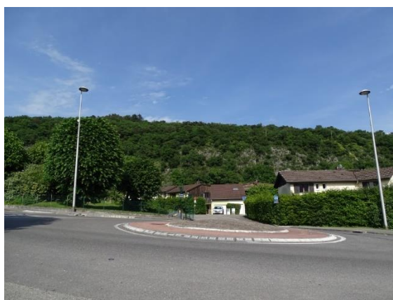
Colline de Corsuet vue depuis la RD991 au lieu-dit « Mémard » - la zone du réservoir n'est pas visible
