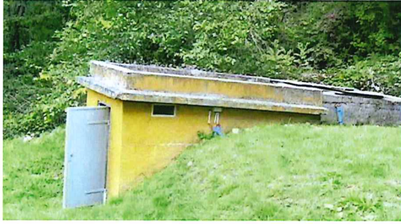
Chambres de captage (amont et aval)
