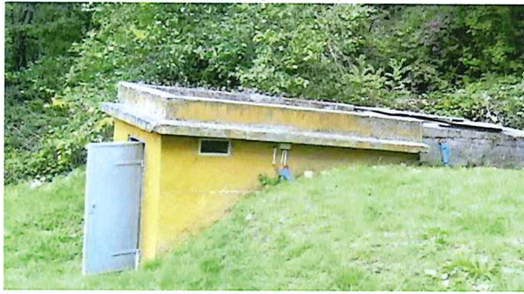
Chambres de captage (amont et aval)
