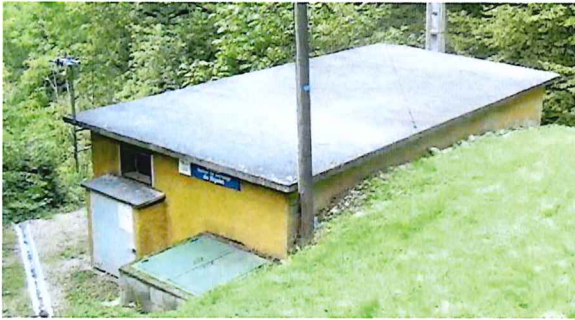
et la chambre de distribution
