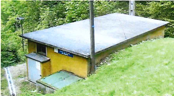
et la chambre de distribution
