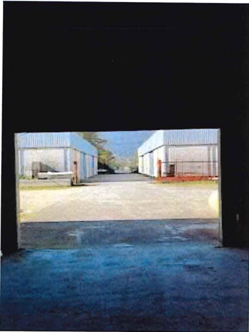
Porte d'entrée de la partie hangar.
