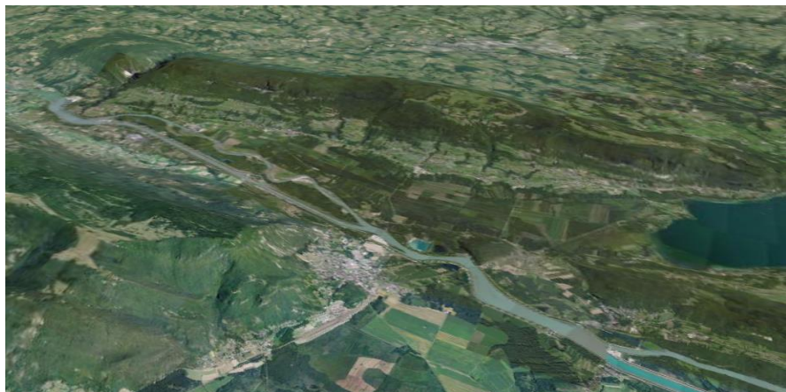
Figure 5: Orthophotographie de la Communauté de communes de Chautagne
