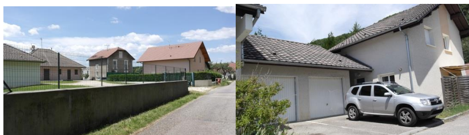
La trame résidentielle-hétérogénéité des formes bâties par ailleurs très consommatrices d'espace
