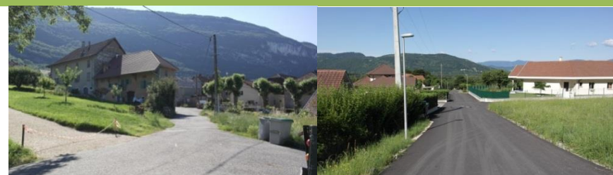
Bâti traditionnel en contrebas
