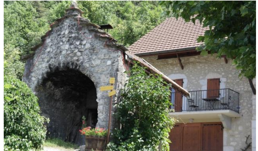
Motz-Four à pain avec pignon à redents anciennement couvert de chaume http://www.savoie.fr/uploads/Publication/WEB_CHEMIN_14266_1259245698.pdf
