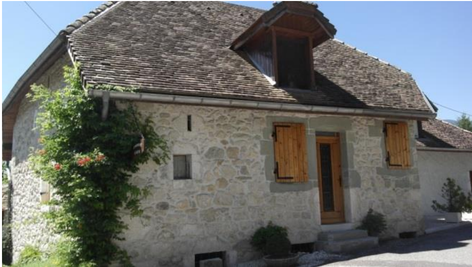
Maison dauphinoise restaurée : toit à quatre pans et toiture en écaille.
