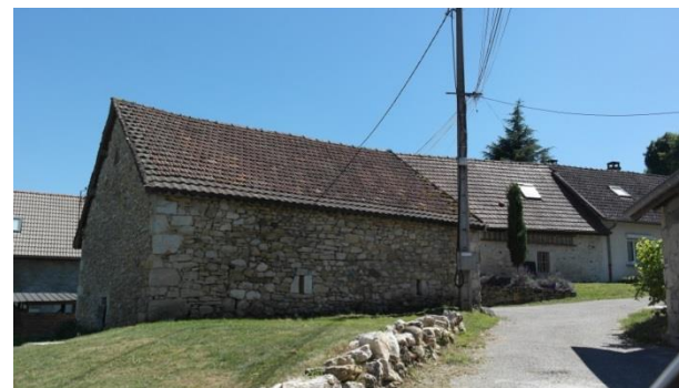
Maisons rurale accolées-Semelaz
