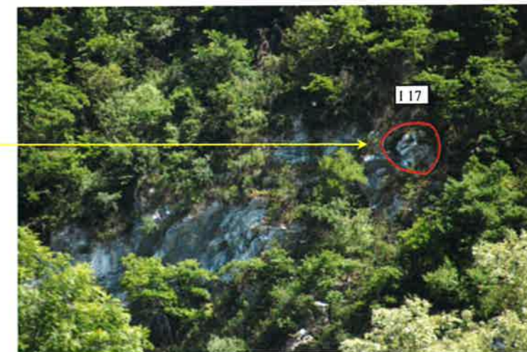
Fig. 35 : zoom sur deux dalles rocheuses \leq m^3 présentant une forte probabilité de départ (I 17).
