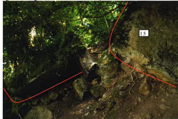
Fig. 13 : colluvions en pied de versant, avec inclusion de gros blocs (I 5) se déchaussant en amont de la maison Maurrier
