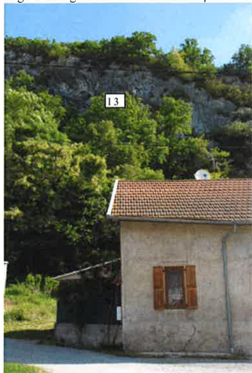
Fig. 8 : instabilités 3 – barre C, dominant la maison Michaud
