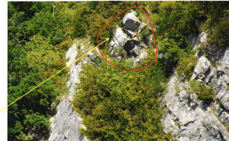
Fig. 21 : vue rapprochée de l'instabilité 10 (≈ 2 x 1 m 3 )
