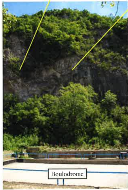
Fig. 29 : masses rocheuses très altérées et décollées de la paroi, générant un risque élevé d'éboulement d'une centaine de mètres cubes à l'extrémité nord du bouldrome (I13, à droite). Fig. 30 : autres instabilités \leq m^3 en amont du bouldrome (I14).
