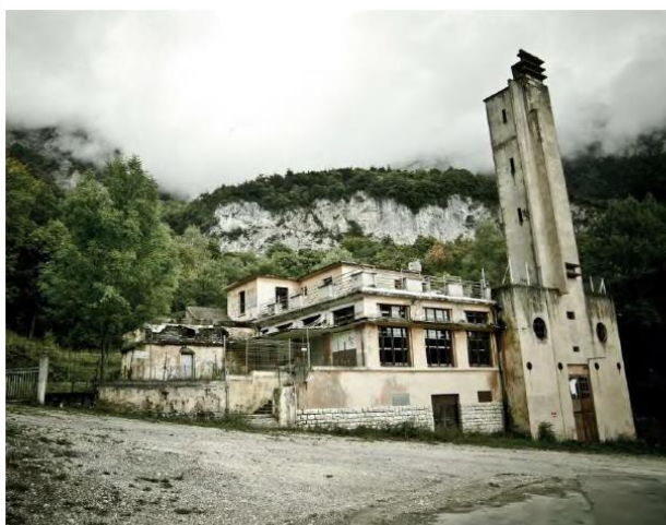
État actuel du bâtiment
