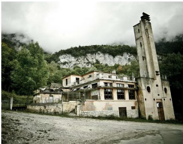
État actuel du bâtiment
