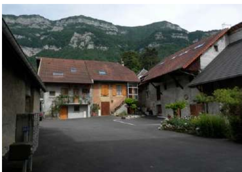
MERY - imperméabilisation de la cour centrale
