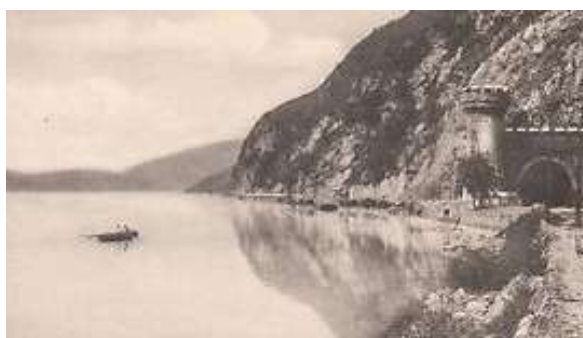
Tête du tunnel de Brison
