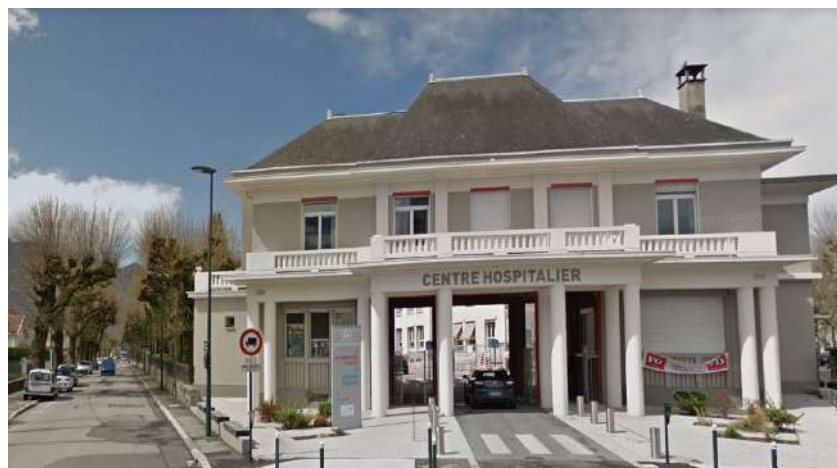
Hôpital Grand Port d'Aix-les-Bains
