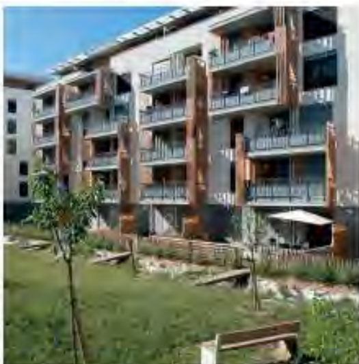
Exemple de noue plantée dans l'éco-quartier de Vallin-Fies à Arvieux (74)
