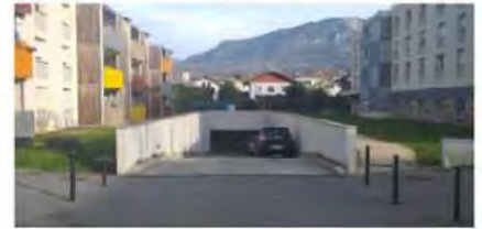
Trémie de parking souterrain en cour d'ilot (Alais-B., Lafin, 2020)
