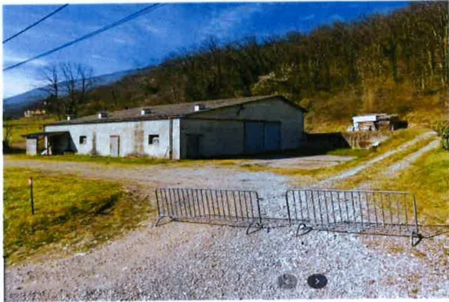
Hangar situé sur notre propriété (1109 route du Relais 73 370 LE BOURGET-DU-LAC)
