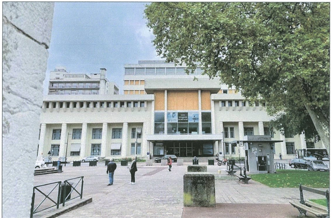
Le bâtiment des anciens thermes d'Aix-les-Bains a été entièrement désaffecté et désamianté. Photo Le DL/P.-E. B.
