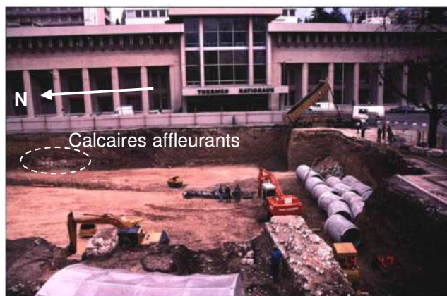
Figure 15 : Photos des travaux de terrassement du parking de l'Hôtel de ville (SAS Savoie, annotées)
