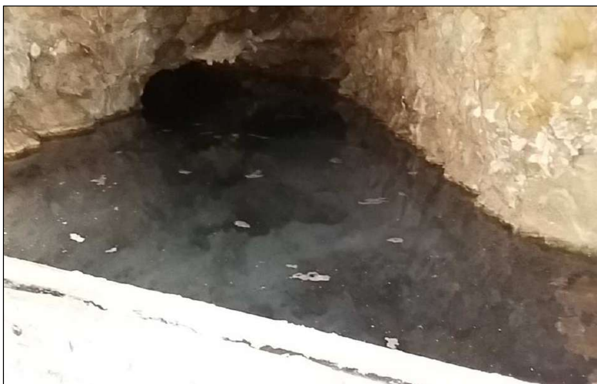
Figure 8 : Vue de l'arrivée de la galerie karstique de la source Soufre (photo BURGEAP)
