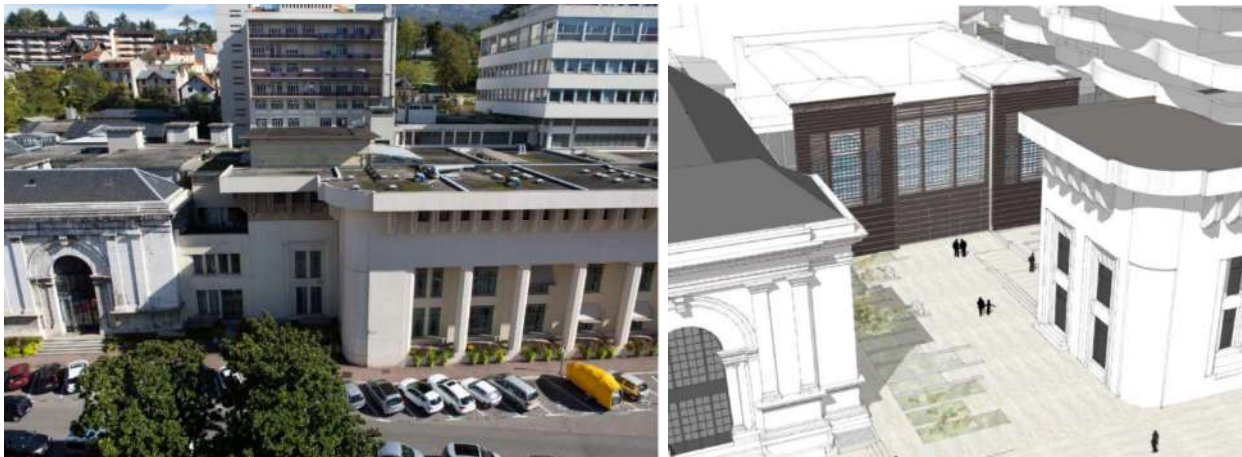
Bâtiment Revel façade Ouest état actuel (gauche) photographie © Thierry CHENU - Du Ciel dans Vos Images, 2012 – Projet bâtiment Revel façade Ouest – PC
