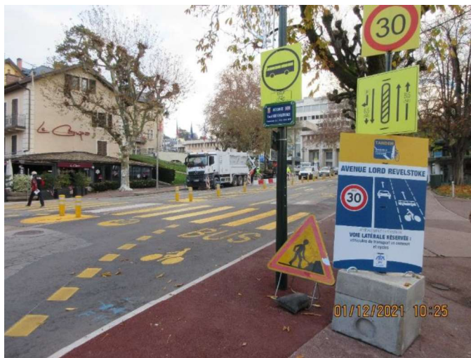
Aménagements temporaires sur l'Avenue Lord Revelstoke
