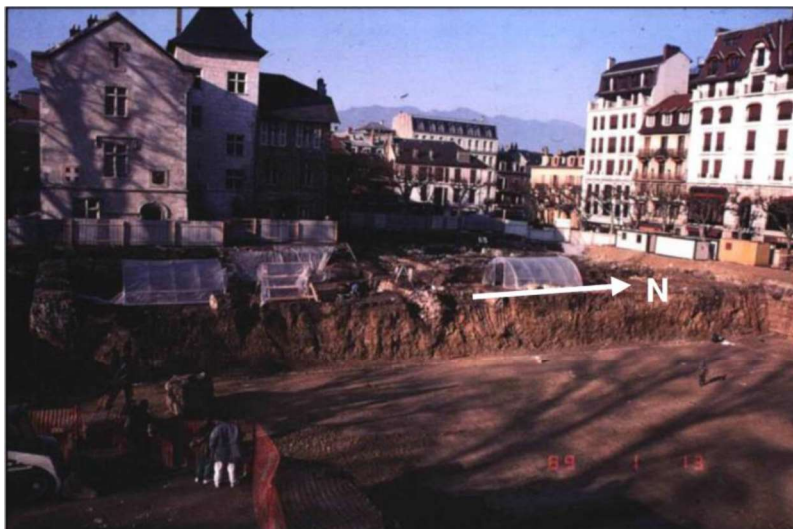
Photo 6 : Photos des travaux de terrassement du parking de l'Hôtel de Ville (SAS Savoie, annotées)
