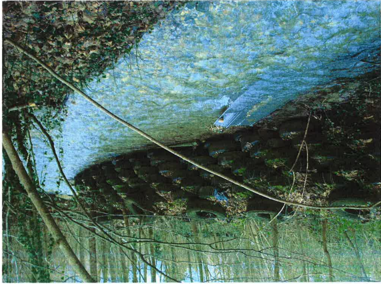
Digue en pneusol rive gauche à l'amont de la confluence avec le Nant Varon
