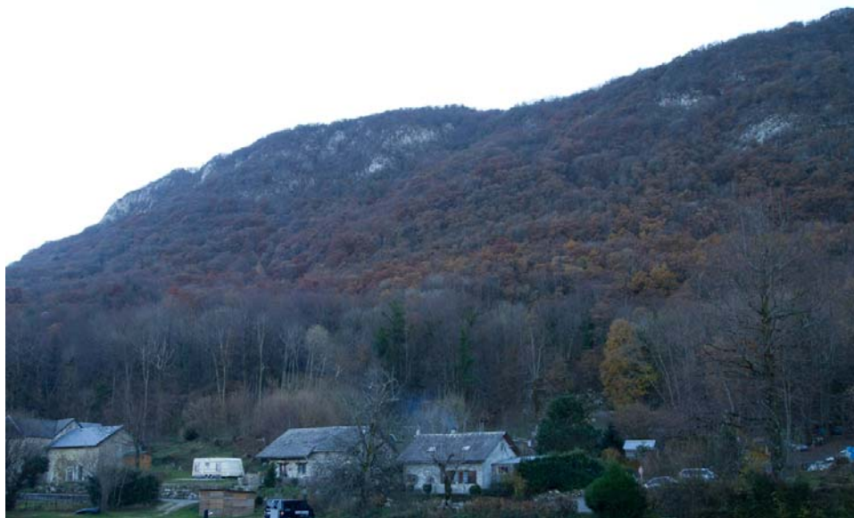
Les affleurements rocheux jurassiques au-dessus du Grand Villard
