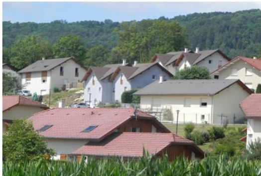
d- Etalement urbain sur les coteaux
