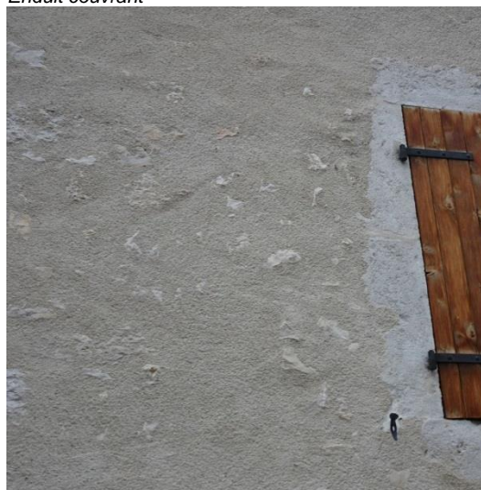
Enduit à pierre-vue
