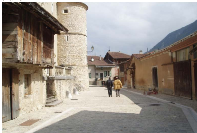
Exemple: pavés jointoyés au sable (sol perméable) et stabilisé (Chabrillan, Drôme)
