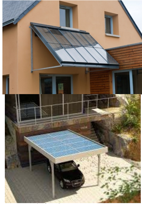
Intégrations sur un auvent ou en annexe
