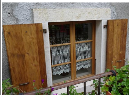
Fenêtre refaite, Chanaz
