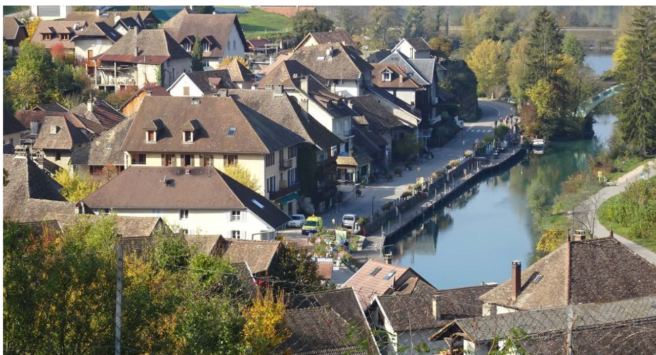
A Chanaz la perception des toitures est primordiale !
