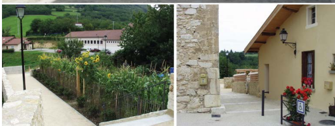
Valorisation des espaces publics du centre-village de Saint-André-en-Royans : utilisation de pavés calcaires (Source : Fiche référence CAUE 38)
