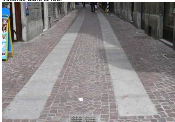
Pavés de Porphyre pour l'ensemble de la rue et dalle de pierre pour les bandes de roulement (Chieri, Italie)
