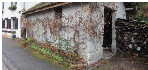
Chanaz : pied de mur végétalisé
