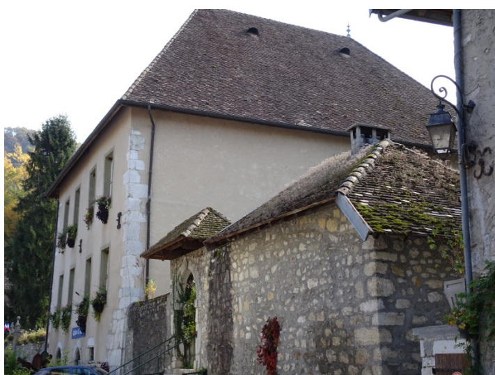
Mur de clôture et porche couvert
