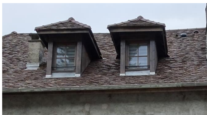
Lucarnes à croupe, en pleine toiture
