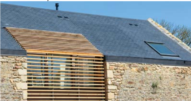
panneau solaire thermique Thermoslate invisible (sous tuiles)
