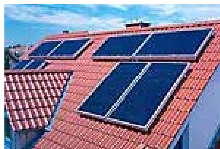
les panneaux posés en superposition, les cadres de teinte différente, le manque d'organisation.
