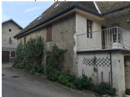
Pied de mur perméable et végétalisé
