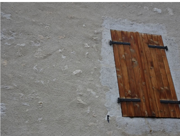
Enduit à pierre-vue
