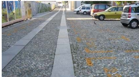
Calade pour l'ensemble de la rue et dalles de granit pour les bandes de roulement (Turin, Italie). Ce mode de disposition permet d'amoindrir le bruit du passage des voitures dans la rue.
