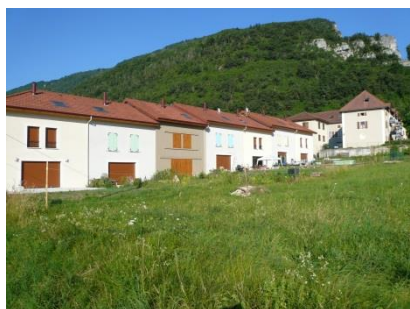
Cognin les Gorges (38). Une opération de 7 logements en cœur de village. Le léger décroché des volumes pour suivre la pente du terrain casse ce volume continu. Il est accompagné par un léger décalage des volumes en plan.
