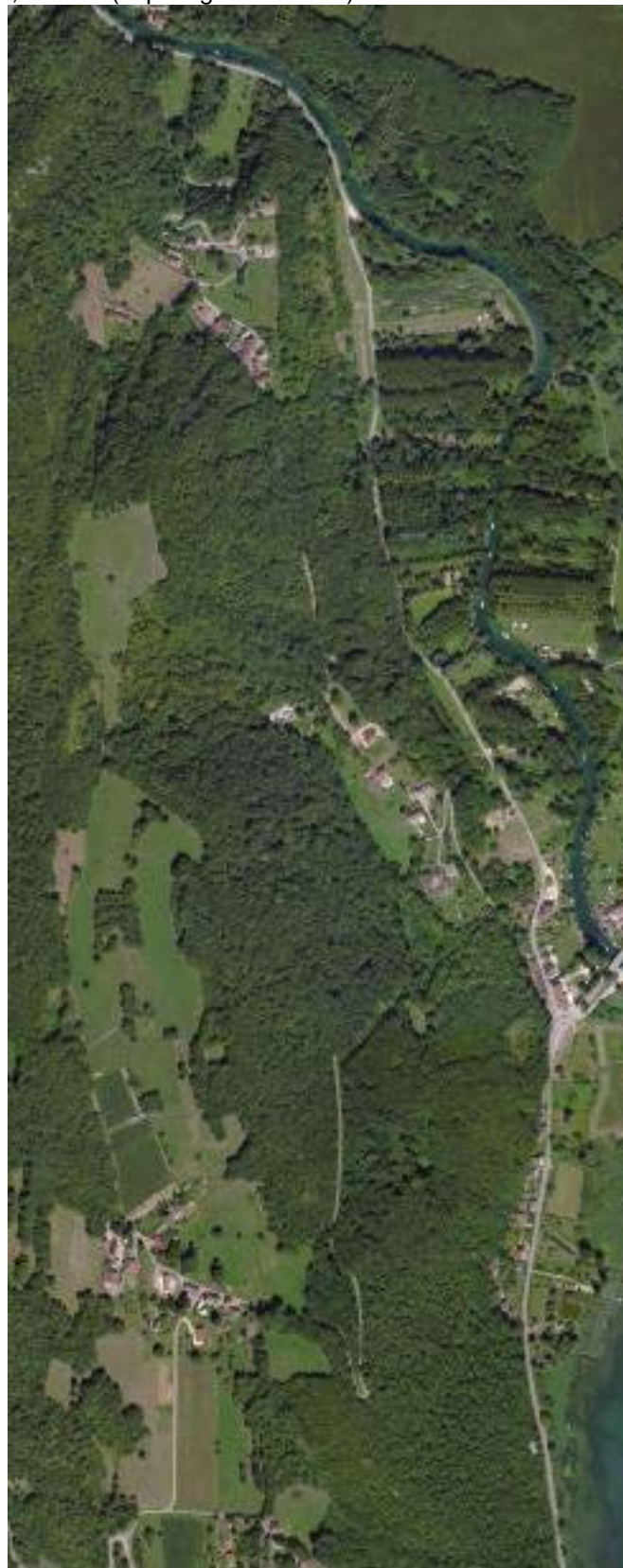
Source IGN Géoportail– Photo aérienne actuelle
