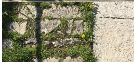
Sol ancien du quai du canal de Savières
