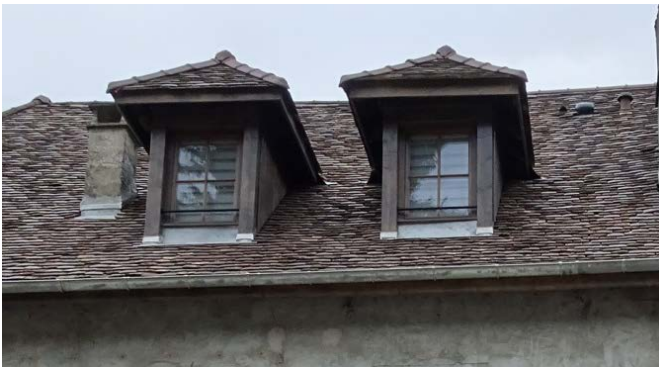
Lucarnes à croupe, en pleine toiture
