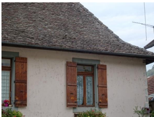
Coyau (la pente du toit s'adoucit) Rue de Boigne
