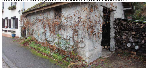
Chanaz : pied de mur végétalisé
