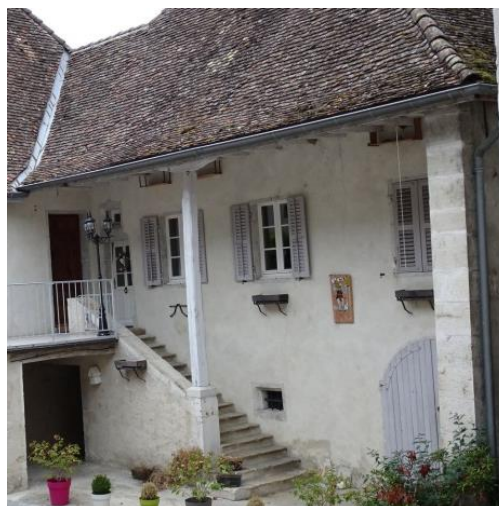
Unité des ouvertures dans cette façade
