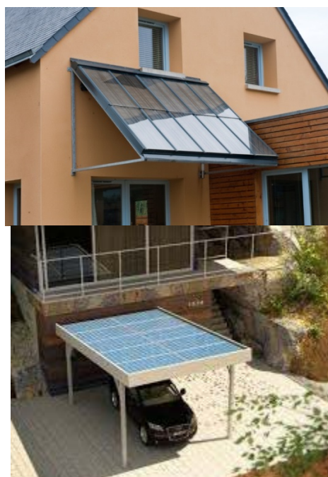
Intégrations sur un auvent ou en annexe
