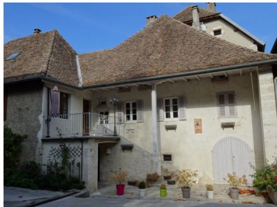
rue de Boigne, logis à l'étage
