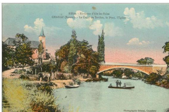
Nouveau pont pour le passage de la route
