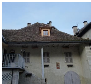
Nouvelle lucarne rue de Boigne, la teinte des bois pourrait être plus sombre pour mieux se fondre dans la toiture
