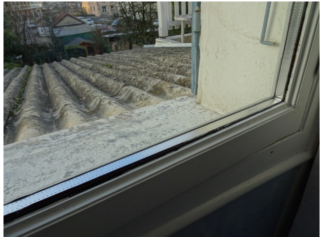
Renforcement du vitrage (DV traditionnel) vu de l'intérieur
