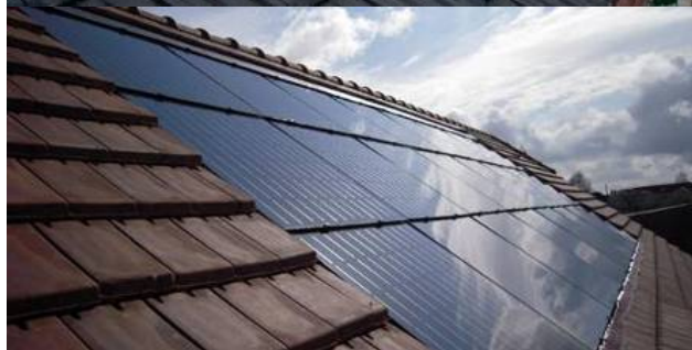
Regroupement des panneaux et intégration dans la couverture, teinte uniforme
