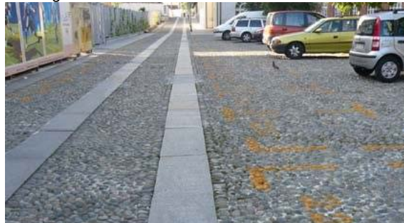
Calade pour l'ensemble de la rue et dalles de granit pour les bandes de roulement (Turin, Italie). Ce mode de disposition permet d'amoinrir le bruit du passage des voitures dans la rue.
