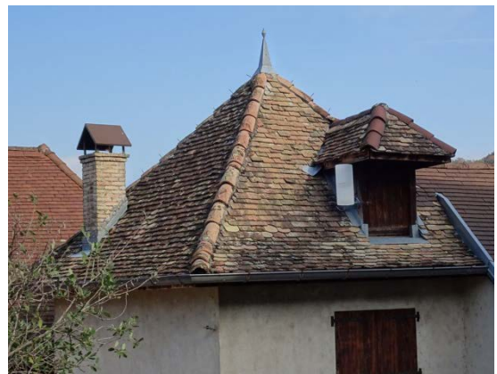
Lucarne en pleine toiture
